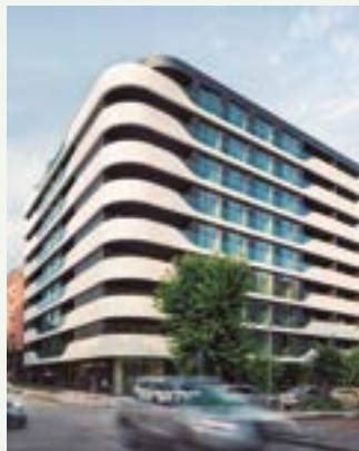
Впечатляваща жилищна сграда в България с ефективно решение за HVAC система. Aquarea
